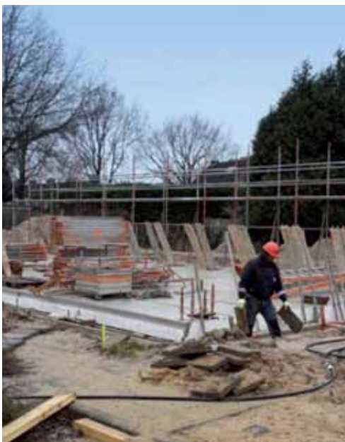
Bouwplaats op 9 januari 2015
