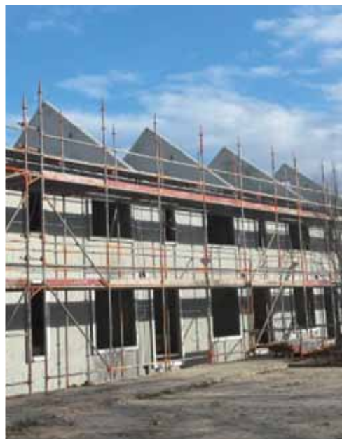
Bouwplaats op 16 januari 2015
